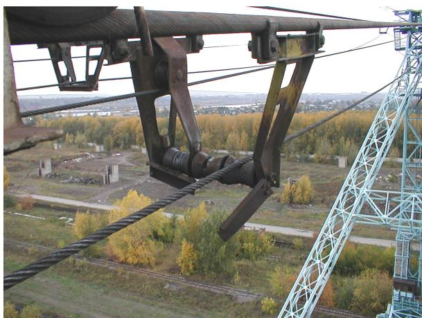
**Рис. 11.** Обрыв нижней связи рейтера, предельный износ поддерживающих роликов кабельного крана.
