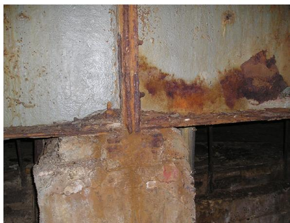
**Рис. 2.** Интенсивная коррозия подкрановых балок и разрушение колонн кранового пути мостового крана.
