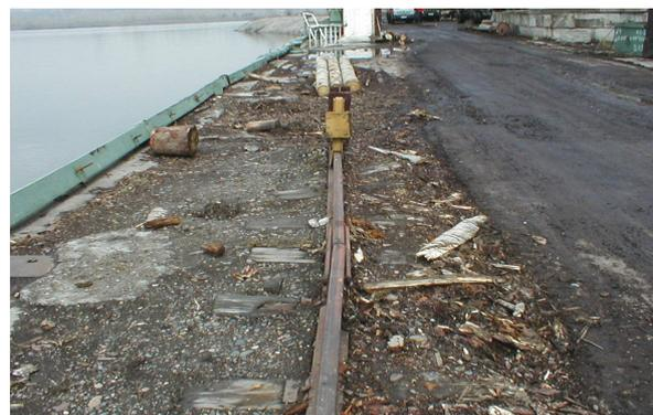
**Рис. 20.** Значительное искривление рельсового пути крана портального КПП-16(20)-30.
