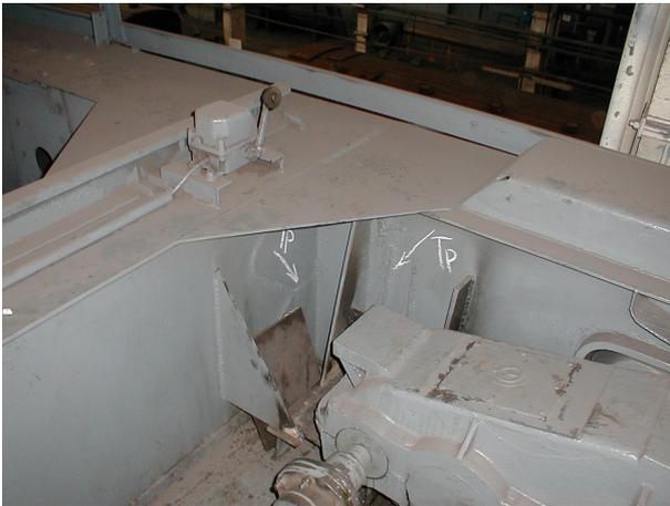
**Рис. 4.** Трещины в месте стыка главной и концевой балок мостового крана.
